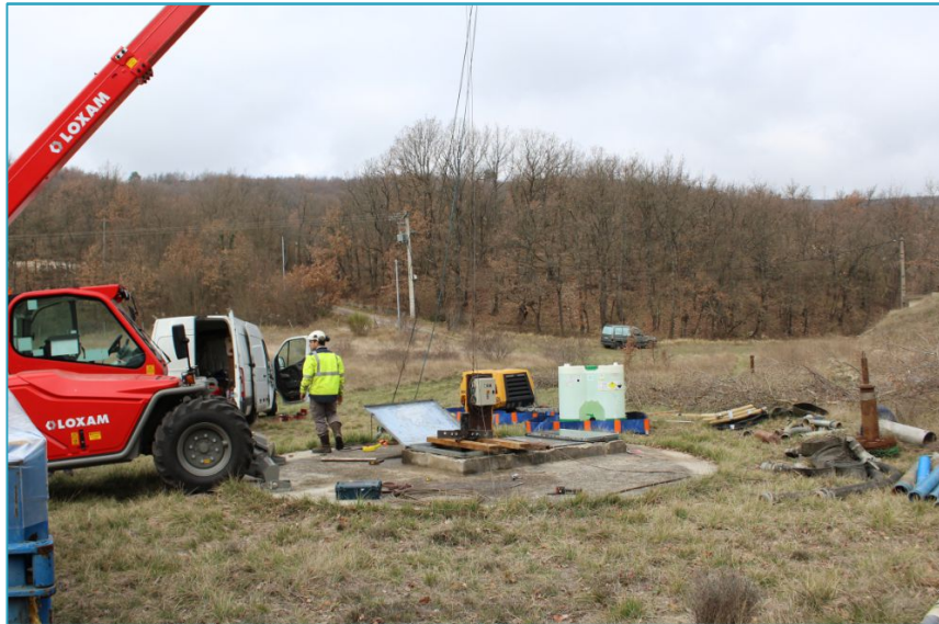
Figure 3 : Vue d'ensemble du chantier
